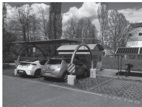
Nun lädt der Benutzer am BFH Carport in Burgdorf sein E-Auto PV-optimiert
