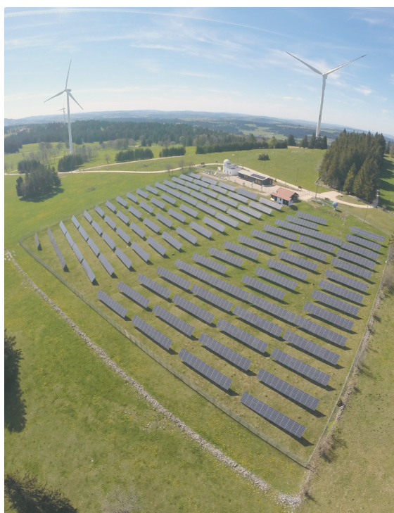
Luftaufnahme PV-Anlage Mont-Soleil
