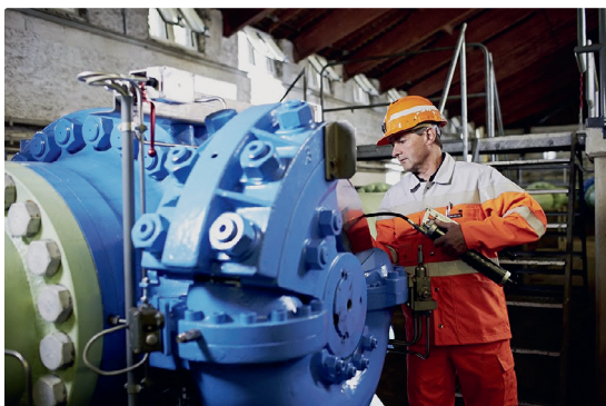
Instandhaltung einer Kraftwerkskomponente
