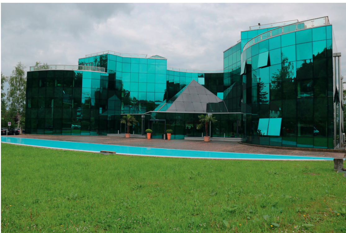
Zusammenarbeit: Abacus-Hauptgebäude in Wittenbach
