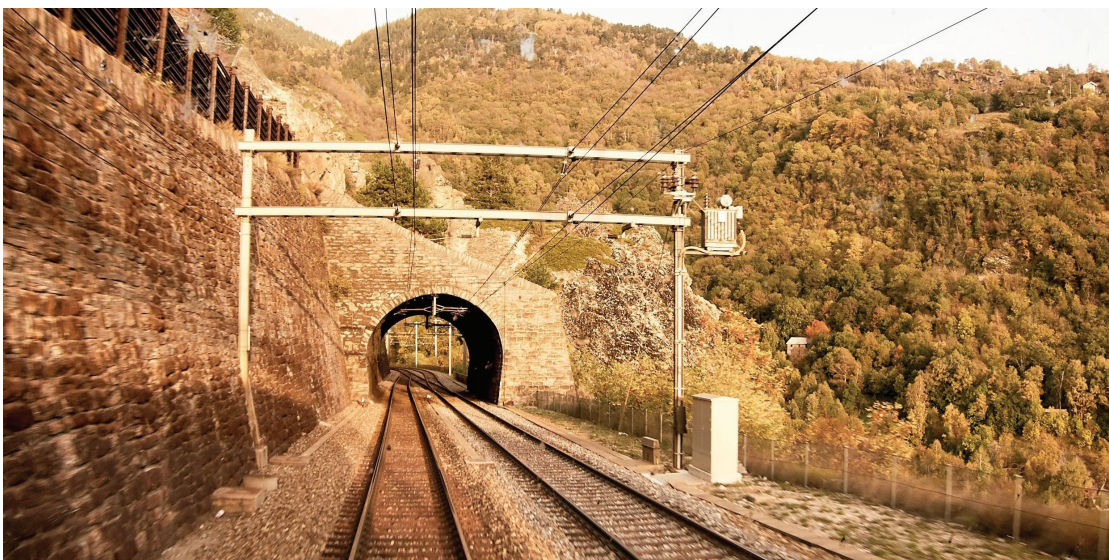
Stützbauwerk angrenzend an Bahnlinie
