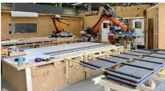
Aktuelle Roboterfertigung in der erweiterten Entwicklungszelle
