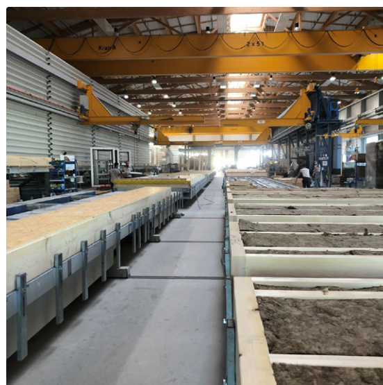
Intérieure de la halle principale de Renggli AG
