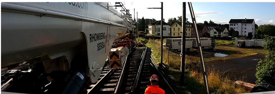
Bildausschnitt der Videokamera auf dem Dach des Gleisbaukrans
