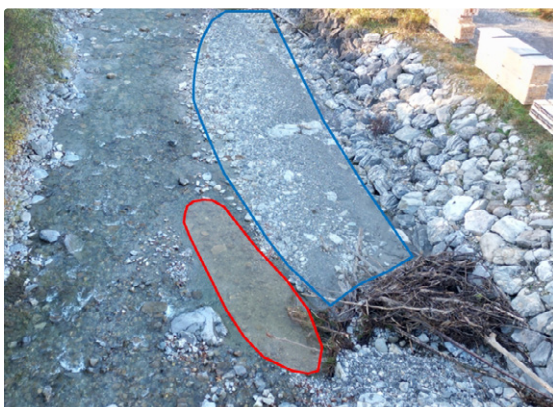
Kolk (rot) und Auflandungen (blau) bei Schwemmholtzrechen an der Emme in Schangnau
