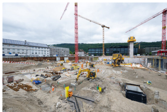
Übersicht Baustelleninstallationen Campus Biel
