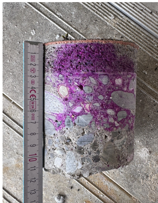
Abbildung 1 – Bestimmung der Karbonatisierungstiefe am entnommenen Bohrkern
